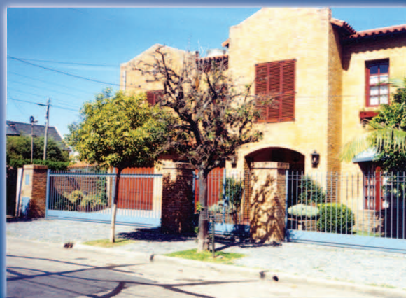
Foto panorámica edificación
