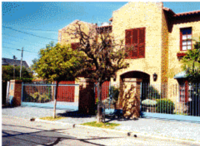
Foto panorámica edificación
